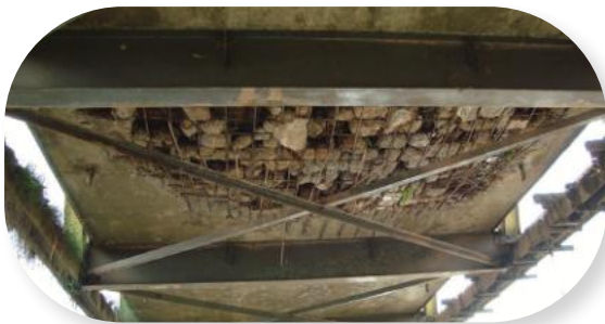
Gambar 2.9 Kerusakan Lantai Jembatan
