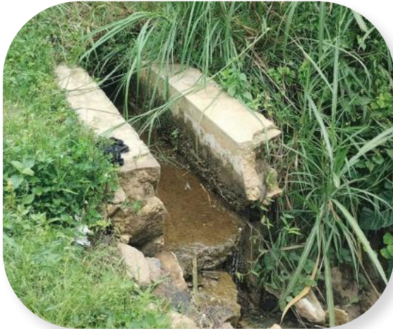
Gambar 4.1 Bangunan Irigasi di Jorong, Padang Rusak
