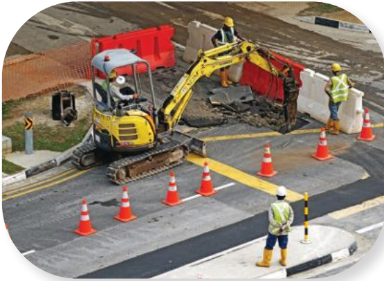
Gambar 3.1 Kegiatan perbaikan jalan dilakukan dengan memperhatikan keamanan dan kenyamanan pengguna jalan.
