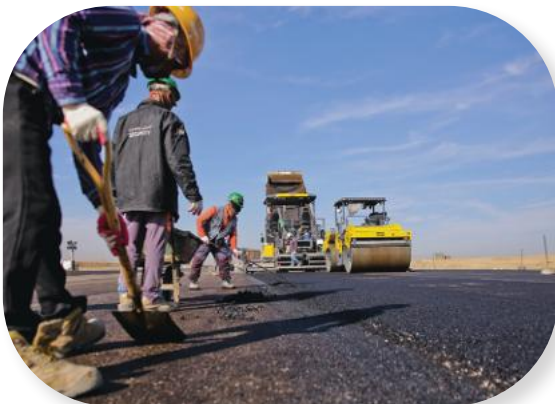
Gambar 3.2 Pekerjaan pengaspalan jalan dilakukan setelah mengidentifikasi kebutuhan pemeliharaan jalan aspal terlebih dahulu.
