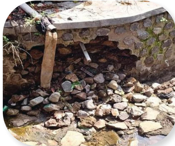
Gambar 4.2 Bangunan Irigasi Ambrol
