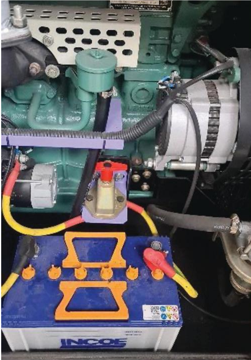
Gambar 4.10 Baterai pada PLTD Sumber: Zainul/Kemendikdasmen (2024)
