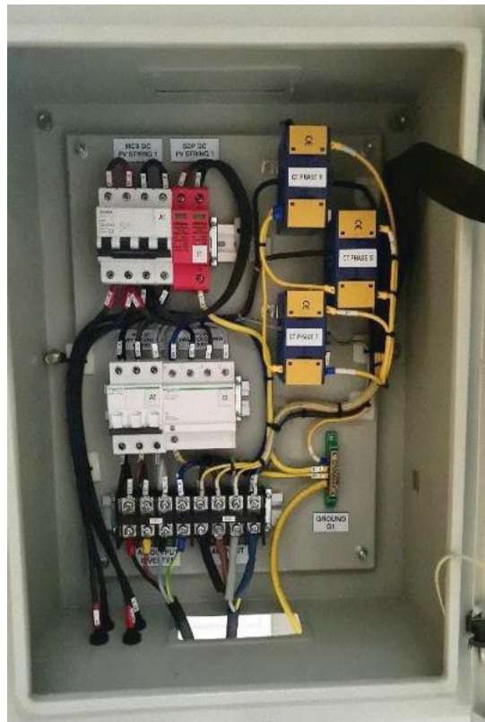
Gambar 4.2 Kotak Kombiner pada PLTS Sumber: Zainul/Kemendikdasmen (2024)
