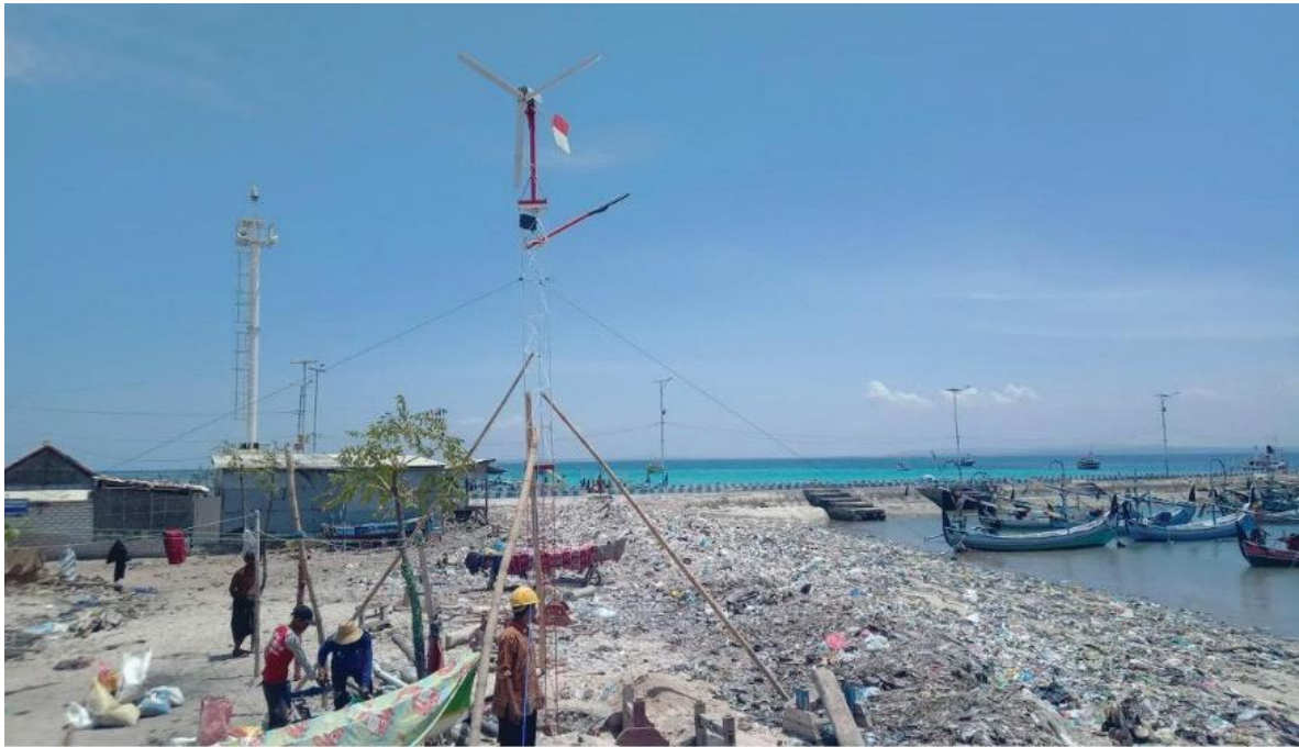
Gambar 3.12 PLTB yang Dibangun untuk Sebuah Komunitas Nelayan Sumber: Amin Wahyono/Kemendikdasmen (2025)
