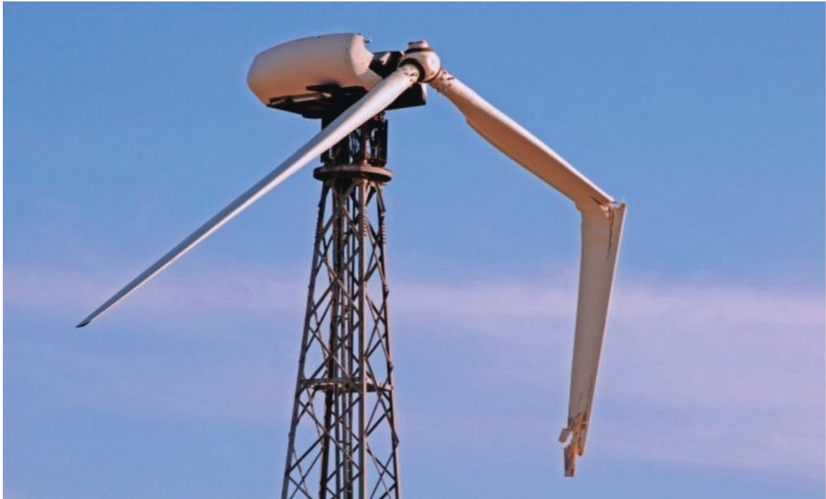
Gambar 3.11 Kipas PLTB yang Rusak Sumber: Mishnaevsky (2022)
