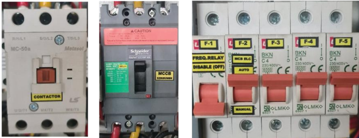
Gambar 2.19 Kontraktor, MCCB, & MCB Sumber: Zainul/Kemdikbudristek (2024)
