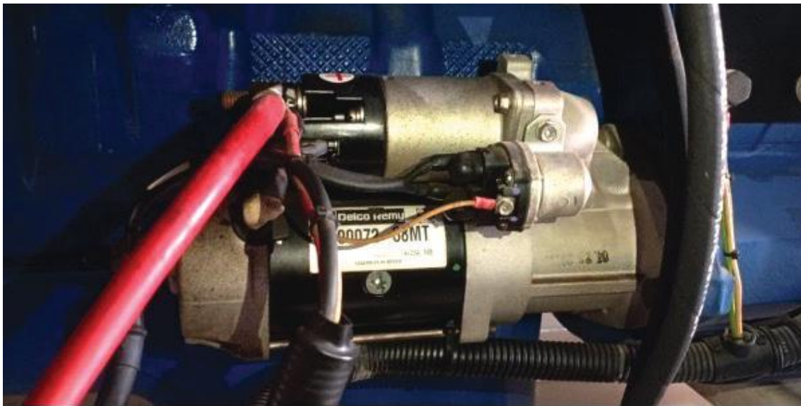
Gambar 4.9 Starting Motor pada PLTD Sumber: Zainul/Kemendikdasmen (2024)
